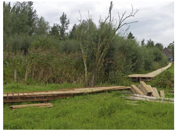
Knuppelpad wordt aangelegd
